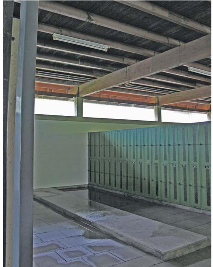
Das Schwimmbaddach ist undicht und muss dringend saniert werden.
